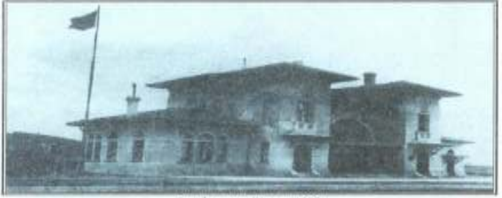
Gazl İstasyon Binası (1927)
