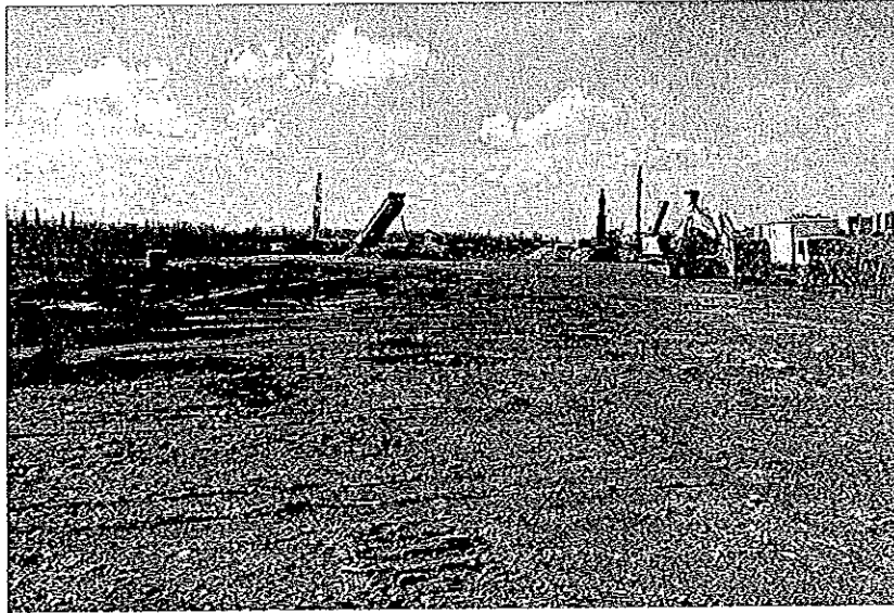
Resim 13. Dava konusu arazilerin doğu bölümündeki yüzey toprağı üzerine iş makineleri ile malzeme serilmesi ve sıkıştırılması çalışmaları
